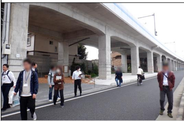
【石神井公園駅付近「高架橋及び側道」】
